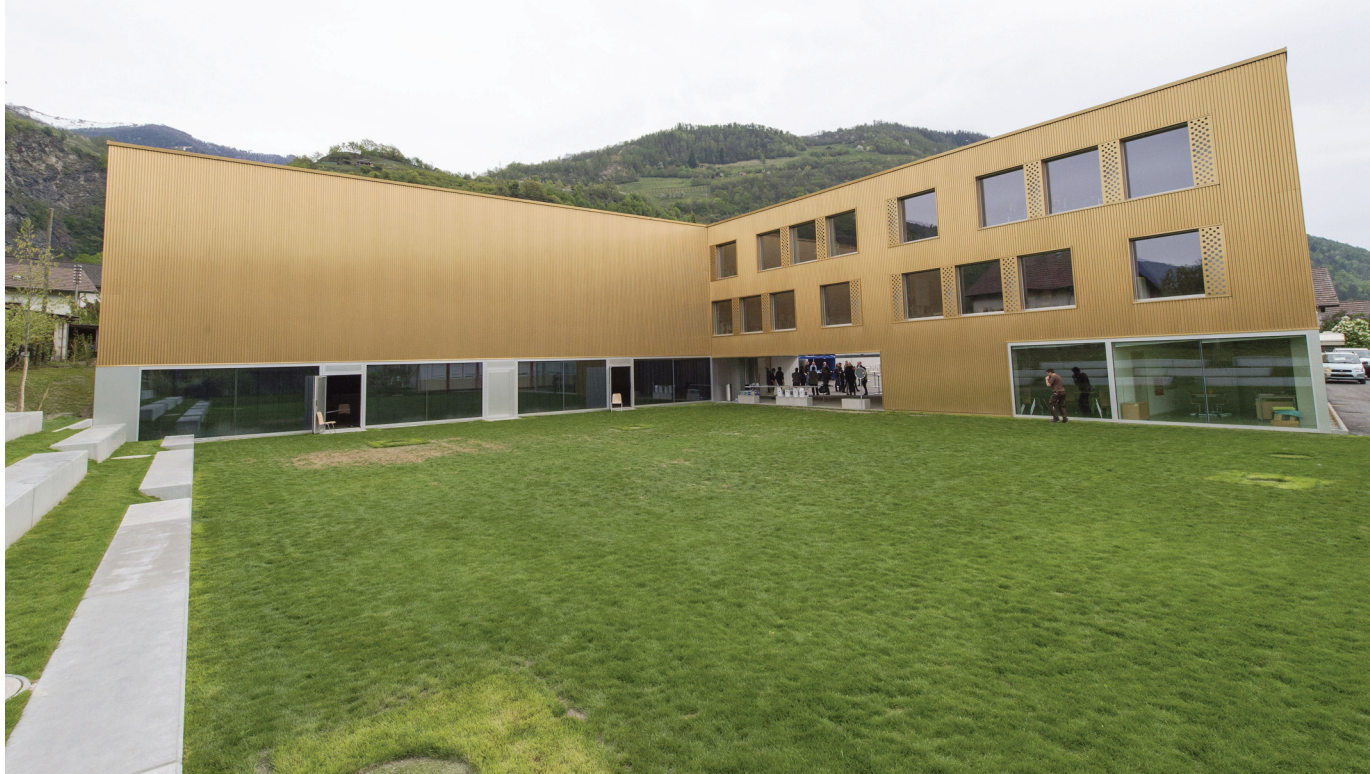
APROZ Inauguré en avril, le nouveau centre scolaire abrite neuf salles de classe et une salle de gymnastique polyvalente. SACHA BITTEL / A
