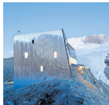
Construction de la cabane de Tracuit, Anniviers (VS), 2013.
