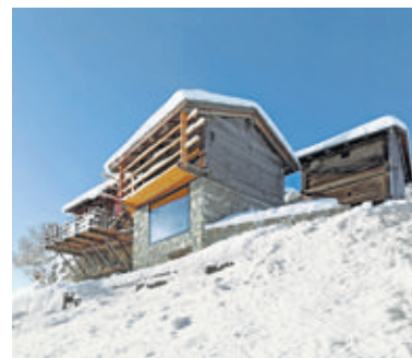
Transformation d'une grange écurie au biolley (VS), 2012.
