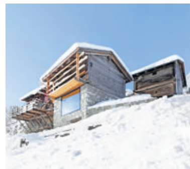
Transformation d'une grange-écurie au Biolley (VS), 2012.
