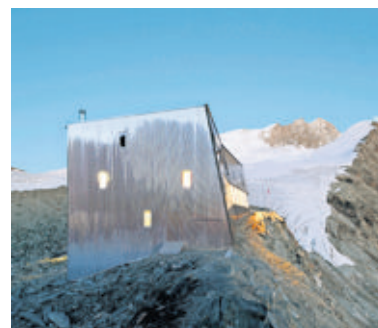
Construction de la cabane de Tracuit, Anniviers (VS), 2013.
