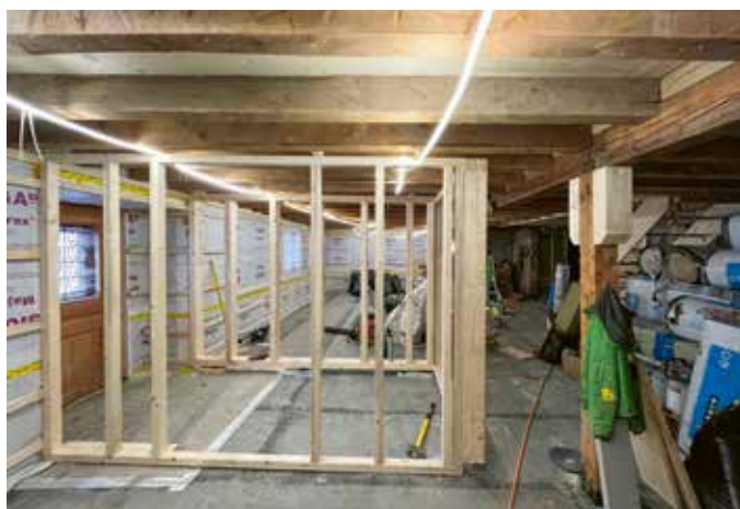
Un chantier à 3000 m (CCV, SAVIOZ FABRIZZI)
